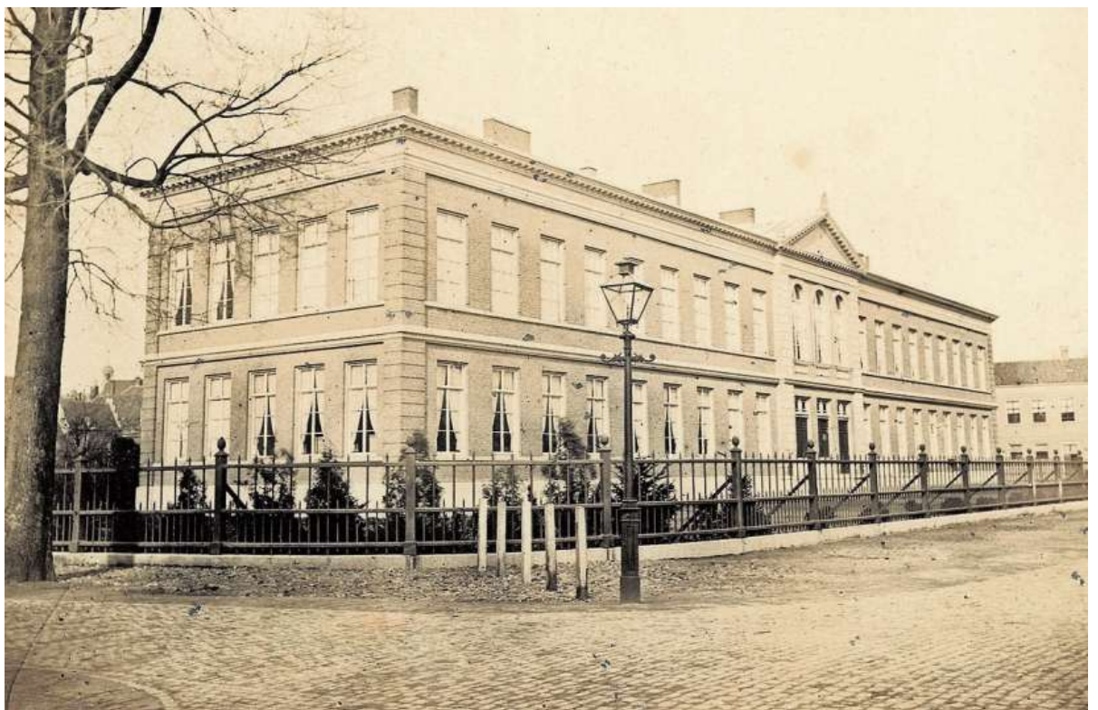
Het laboratoriumgebouw aan de Steenschuur kort na oplevering in 1859.
